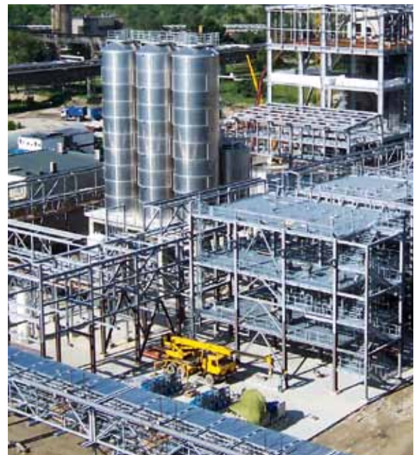
Momentaufnahme einer Linde-Großbaustelle
